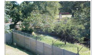
Fig. 37. Hove's Drift bridge
